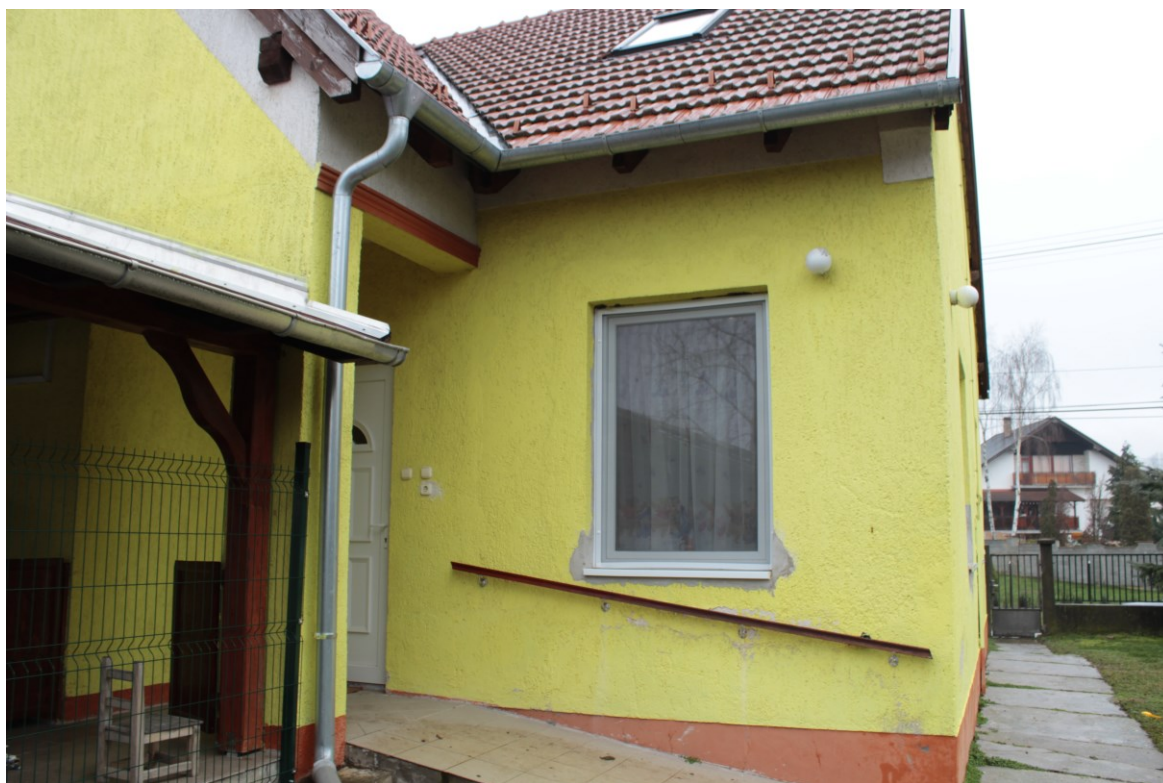
Udvar felőli homlokzat
